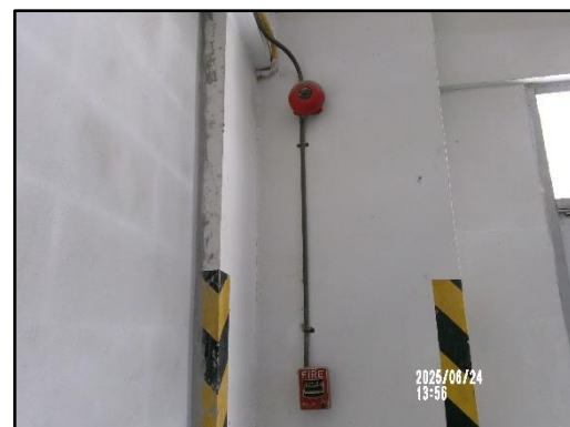
ภาพที่ 2.14 ระบบตรวจสอบตรวจจับ และสัญญาณเตือนภัยแบบอัตโนมัติภายในโครงการ
